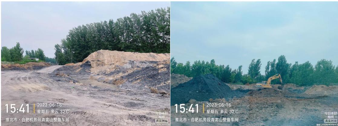
6、比亚迪新能源汽车项目（烈山镇）：该工地部分物料露天堆放未覆盖，内部道路未硬化，场地积尘严重，无车辆冲洗设备车辆出入带泥上路，存在露天搅拌现象，未有任何降尘抑尘措施，正在露天喷漆作业。
