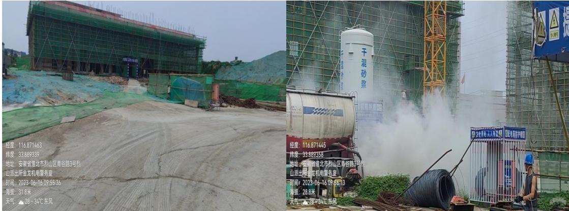
5、张庄铁道旁露天堆场（宋疃镇）：露天堆场大量物料渣土露天堆放未覆盖，挖掘机未湿法作业，道路积尘严重，风吹扬尘较大。
