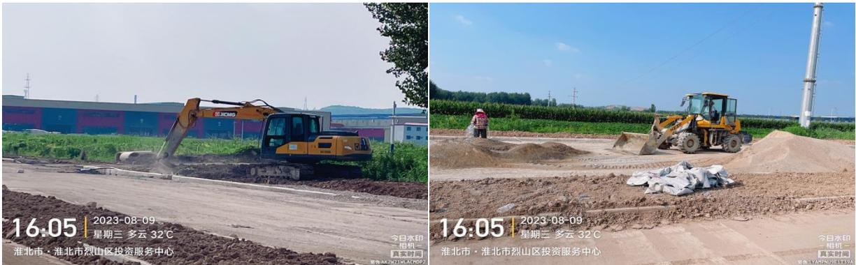
3、杨庄派出所业务技术用房建设项目（杨庄街道）：该工地大量渣土物料露天堆放未覆盖，存在露天搅拌，道路未硬化，无车辆冲洗设备，车辆出入上路带尘严重。（已整改）
