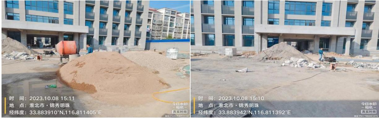
5、融翔悦澜山工程（烈山镇）：现场排查该工地道路积尘严重，车过扬尘明显，大面积裸露渣土露天堆放未覆盖，正在进行露天搅拌混凝土作业，喷淋未开启。建议措施：落实工地扬尘六个百分之百。（已整改回复）
