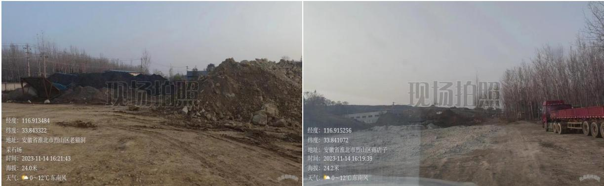
6、鹏淮绿色新型建材（古饶镇）：现场排查该山体修复工程大面积石料山皮未覆盖，挖掘机破碎机未湿法作业，现场未有任何防尘降尘措施，车辆运输扬尘巨大。建议措施:加强监管。（已整改回复）
