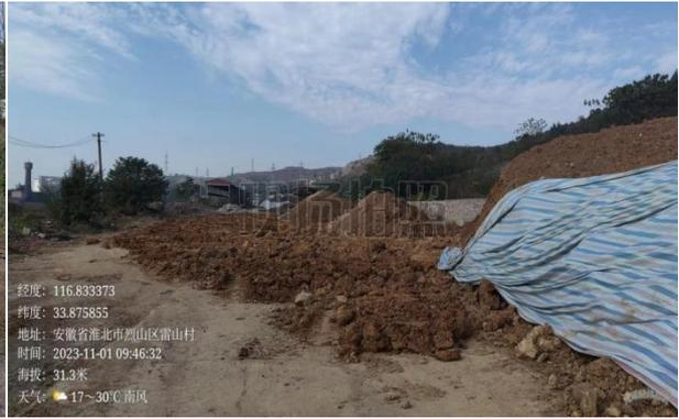
2、新北花园西侧工地（烈山镇）：新北花园西侧工地正在渣土运输作业，扬尘较大，车辆进出未冲洗上路，未设立车辆冲洗装置，车辆出入道路污染严重，挖机作业现场未有任何降尘措施，距离重点区域 3km 以内。（已整改回复）
