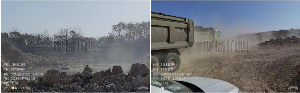
7、高楼山露天堆场（宋疃镇）：高楼山露天堆场，大面积多种物料(煤矸石、石灰、石头、山皮土等)物料露天堆放未覆盖。（已整改回复）
