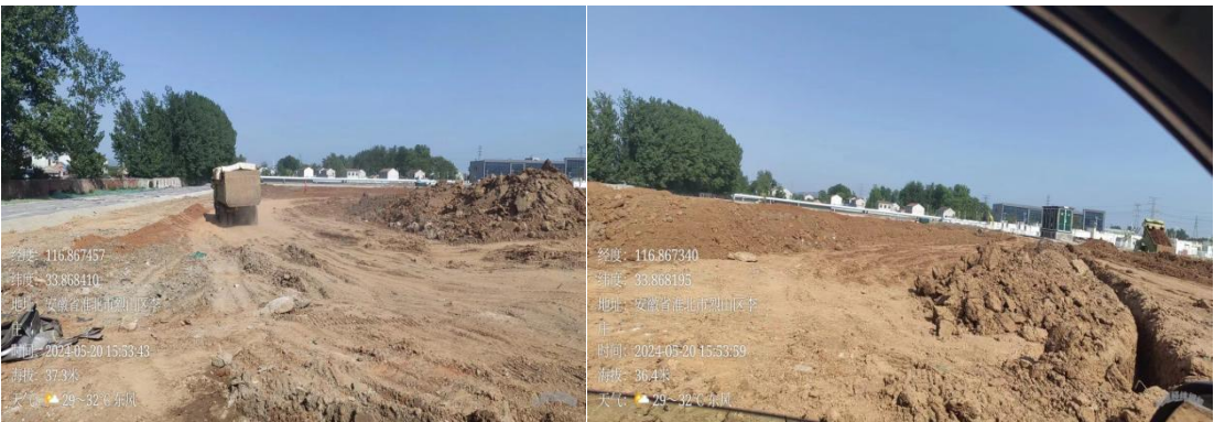
图 11 国安电厂二期项目
