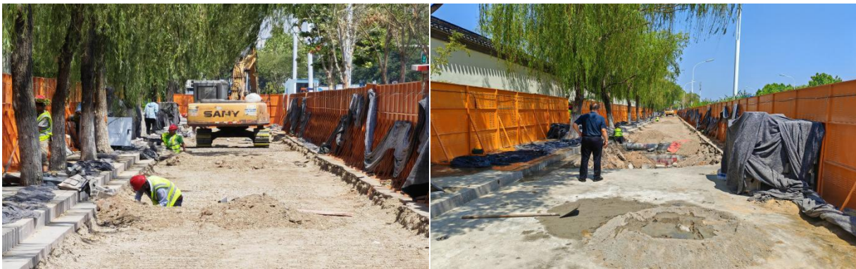
图5 站点周边排水管网升级改造施工
