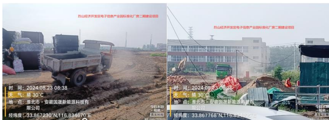
图 6 排查站点周边道路及上风向工地施工情况
