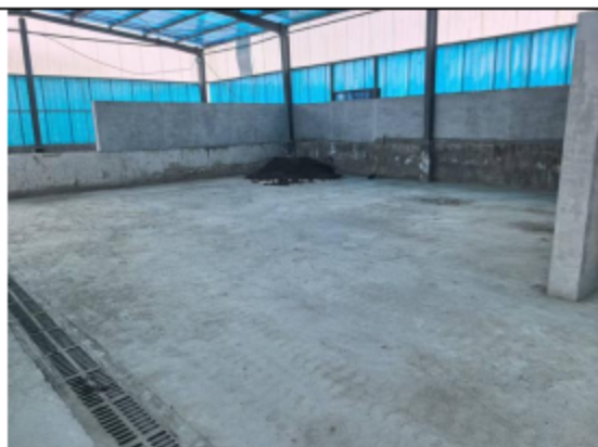
堆肥车间（采用防渗混凝土）
