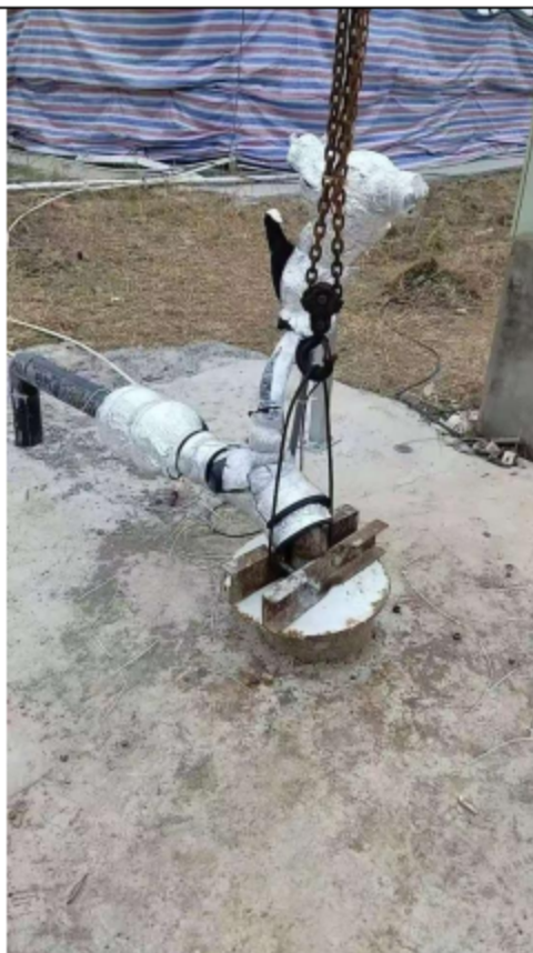
地下水监测井
